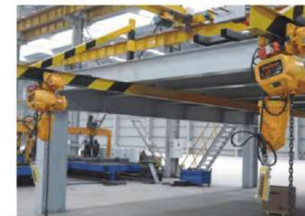
陕汽骏通车辆厂汽车翻转系统工程 SAJT Auto. Flipping System Project
